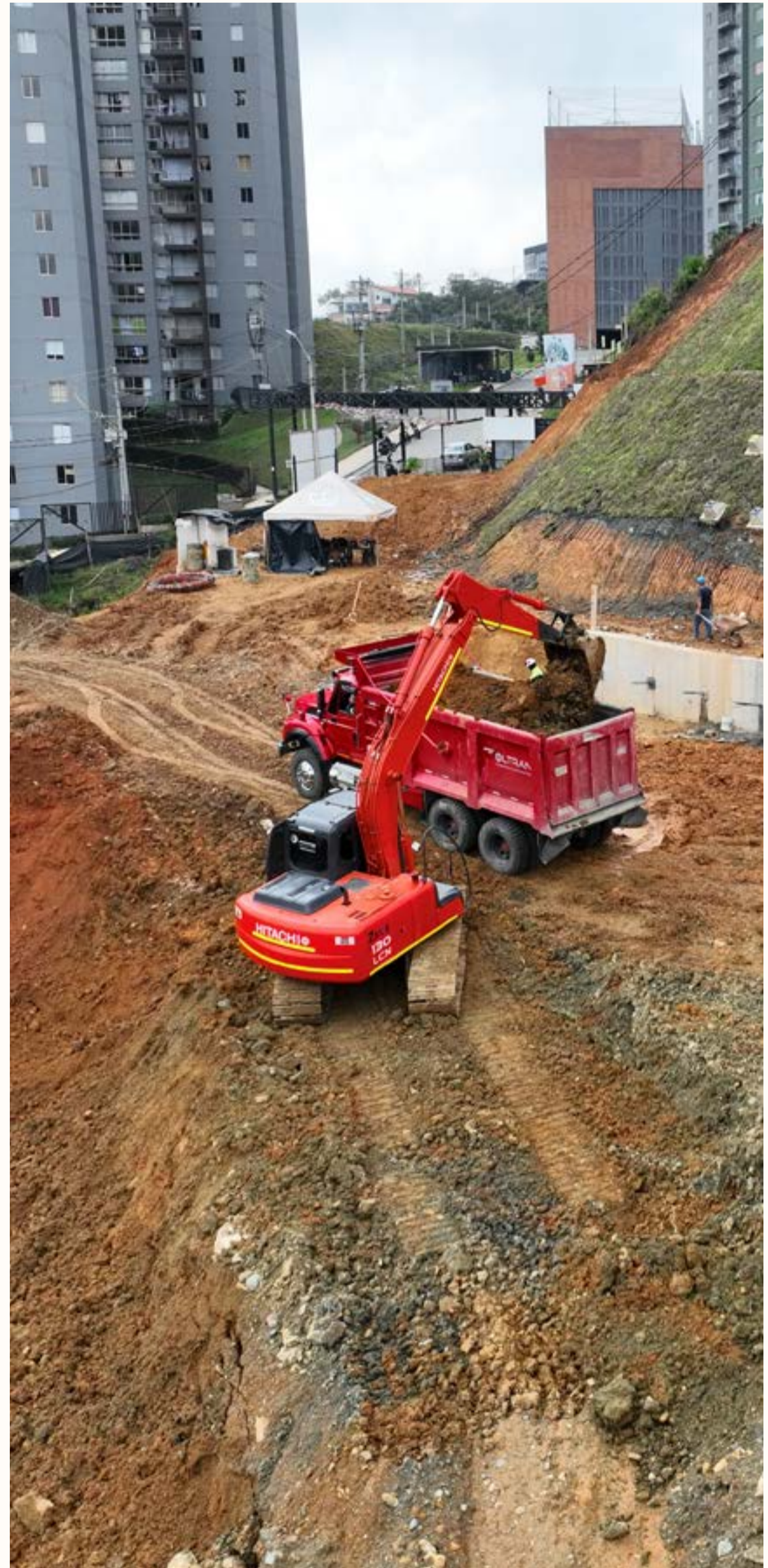
Obra proyecto Jaggua 2025
