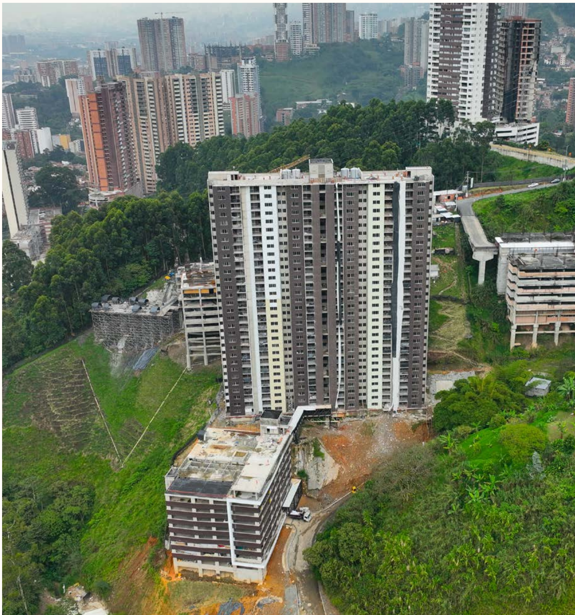
Avance de obra proyecto Kúo
