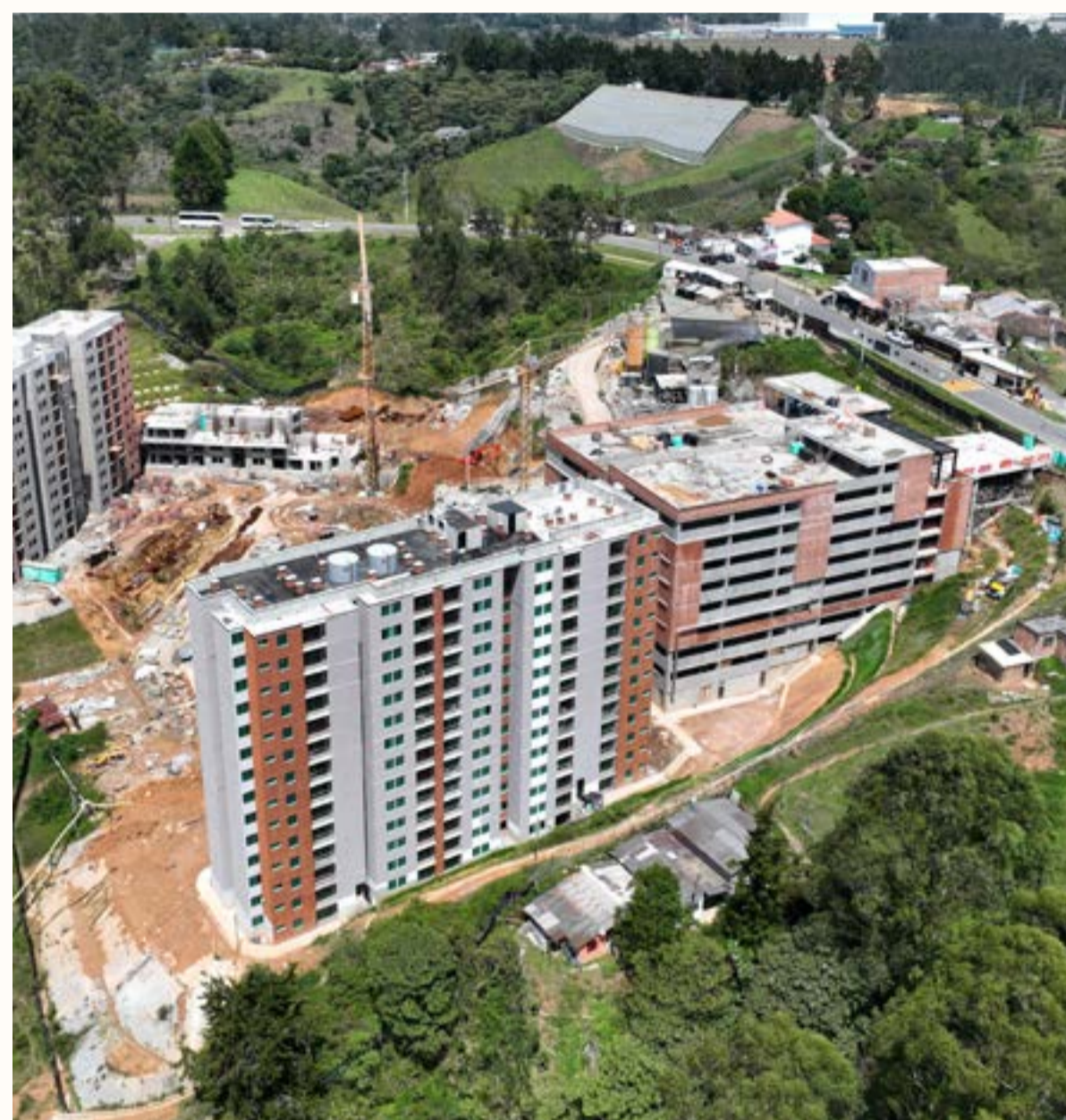
Avance de obra Naté 2025
