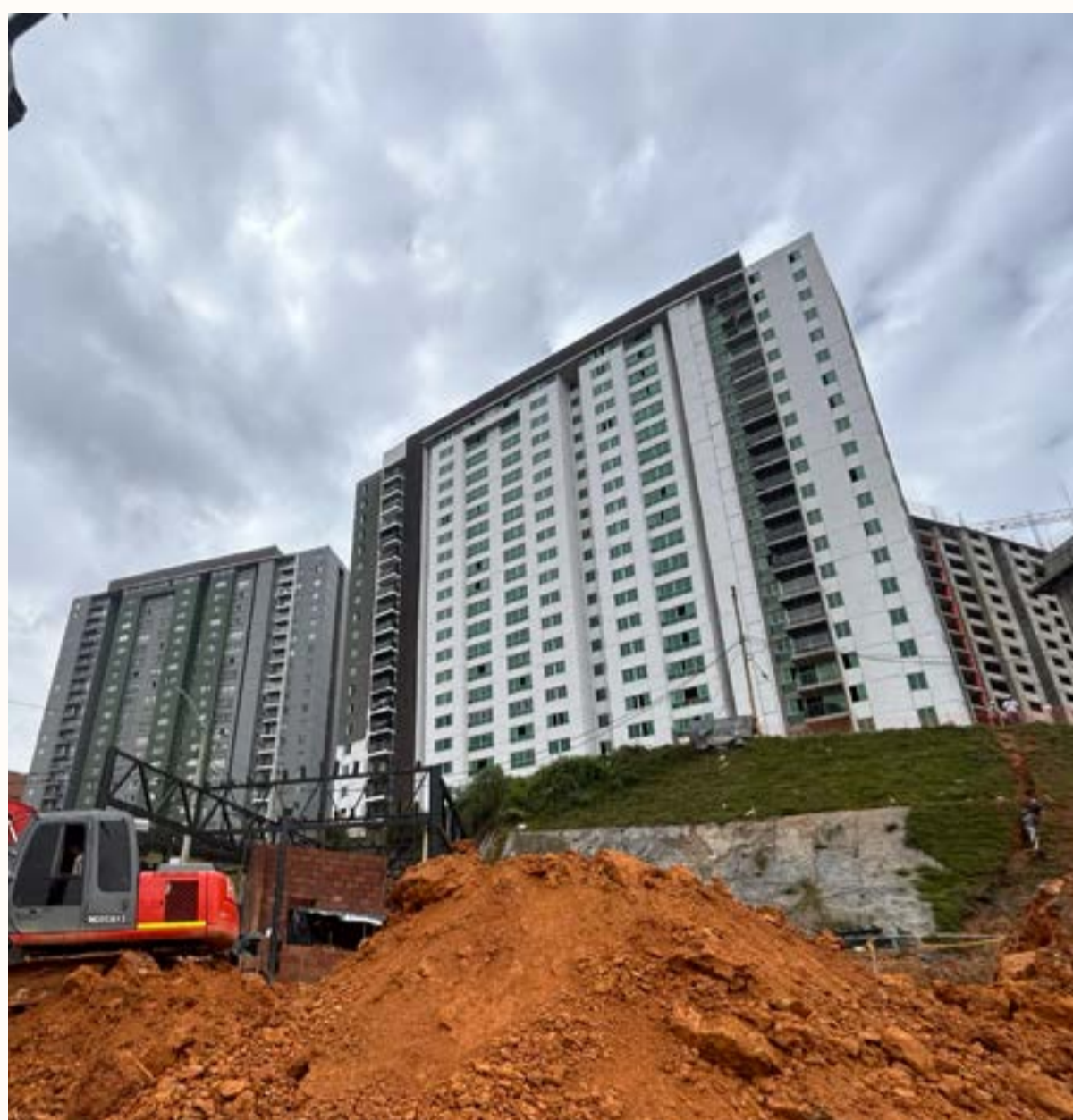
Avance de obra proyecto Jaggua 2025
