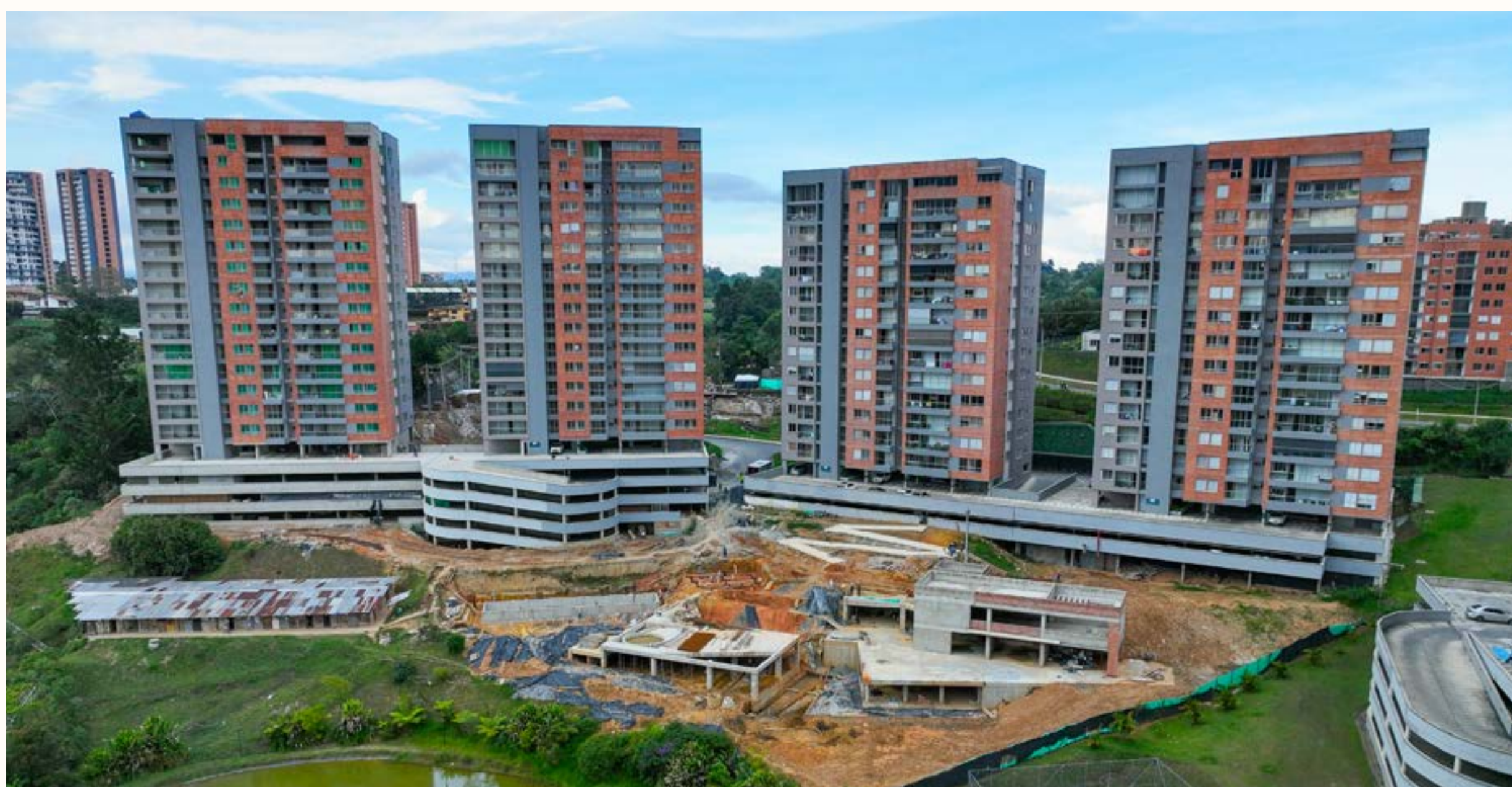
Avance de obra proyecto Aqua 2025
