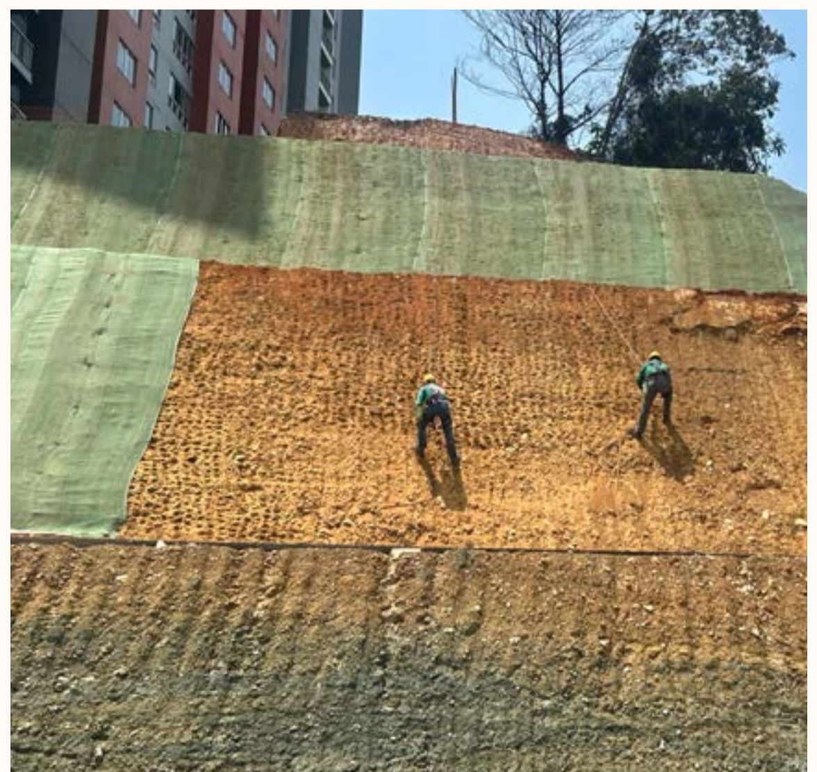
Obra proyecto Jaggua 2025
